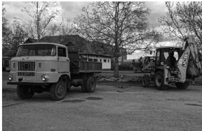
A Zsóry liget pályázat keretében út-, parkoló- és közműépítési munkák zajlanak
