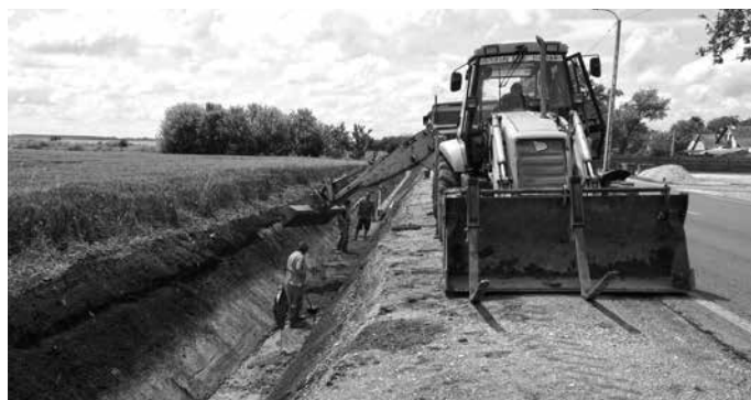
A Zsóry liget projekt keretében az Ostoros-patakba vezető, út menti árok burkolása folyik, illetve a parkoló és az azt kiszolgáló út építése is elindult
