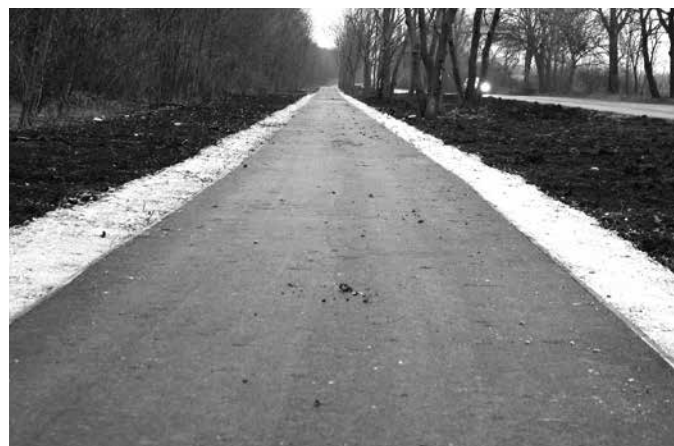
Gyors ütemben halad a kerékpárút építése
